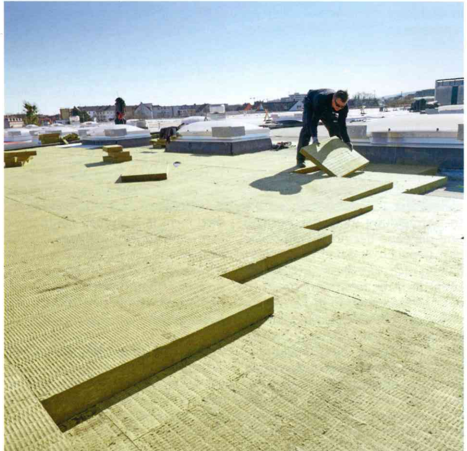
Durch die Kombination der Grunddämmplatte „Hardrock“ mit der Gefälledämmplatte „Georock 038“ wird ein hoch belastbarer, wärmedämmender Dachaufbau mit einem Standardgefälle von 2% realisiert.
