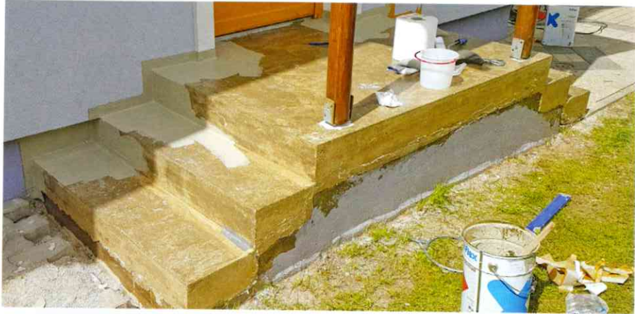
Als erste Komponente des Treppen Beschichtungssystems Triflex TSS trugen die Verarbeiter die Grundierung auf. Anschließend dichteten sie die Anschlüsse mit Triflex ProDetail ab.
