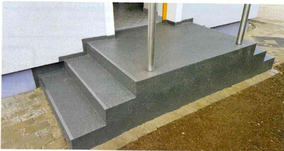
Die Versiegelung Triflex Cryl Finish 205 wirkt durch eingestreuten Quarzsand rutschhemmend. Dank der großen Farbauswahl konnte sie nach Kundenwunsch gestaltet werden.
