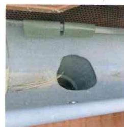
Negatives Fallbeispiel: Der Rinnenausschnitt ist zu klein, die Rinnenschiebenacht fehlt.
