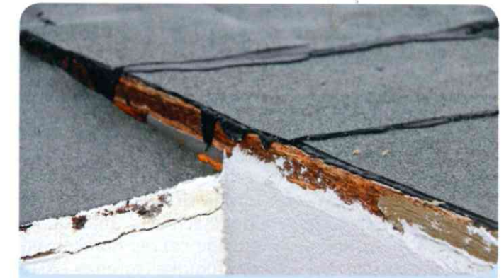
Die Festigkeit der OSB Platte ist in Frage zu stellen sowie auch die Nagelauszugfestigkeit der Patentsaumstreifenbefestigung.
